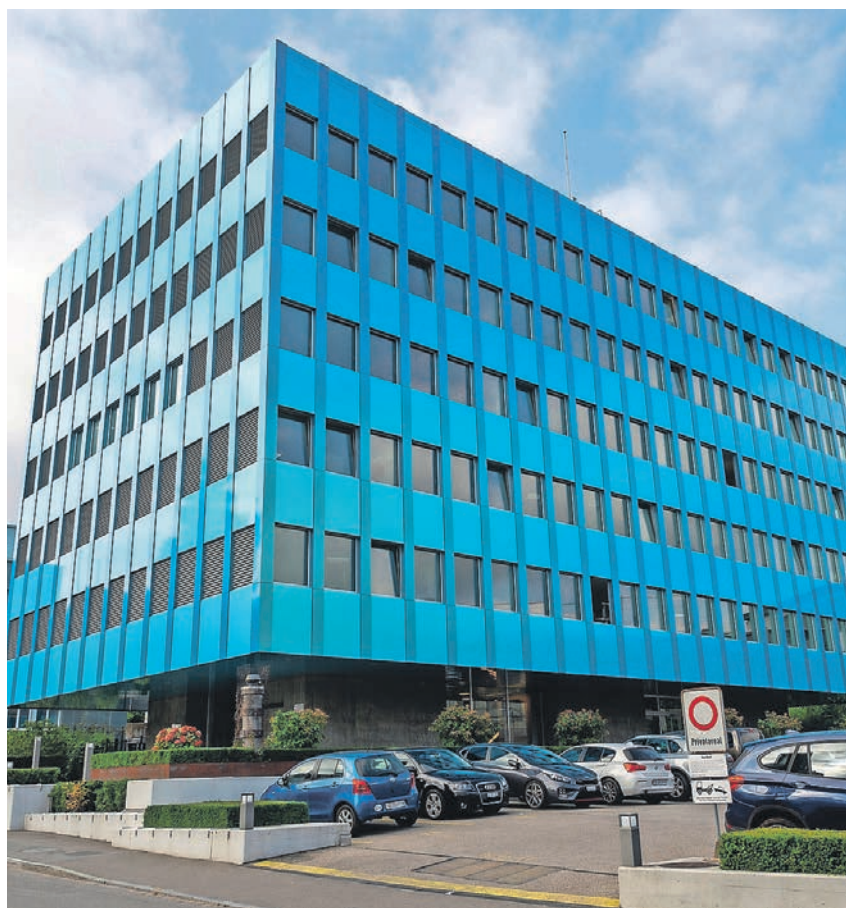
Die neue Fassade des Wielandhauses erstrahlt in neuer Farbe.
